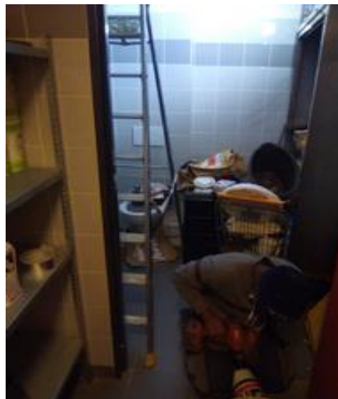
Les seuls sanitaires (hors des chambres) de la zone d'hébergement sont hors service depuis plusieurs semaines
