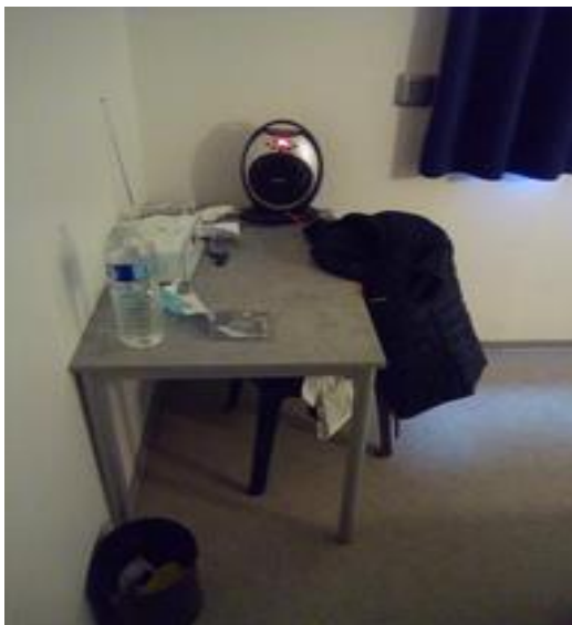
Des convecteurs d'appoint sont placés dans les chambres
