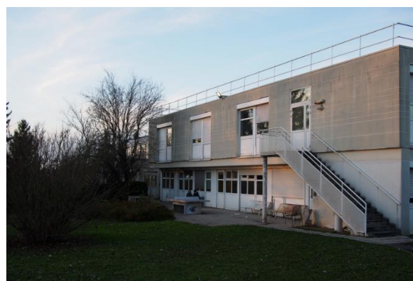
Bâtiment accueillant les unités Henri Claude, Susy Rousset et Mahfoud Boucebci
