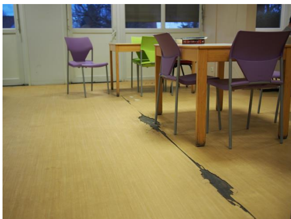
Revêtement du sol de l'unité Henri Claude
