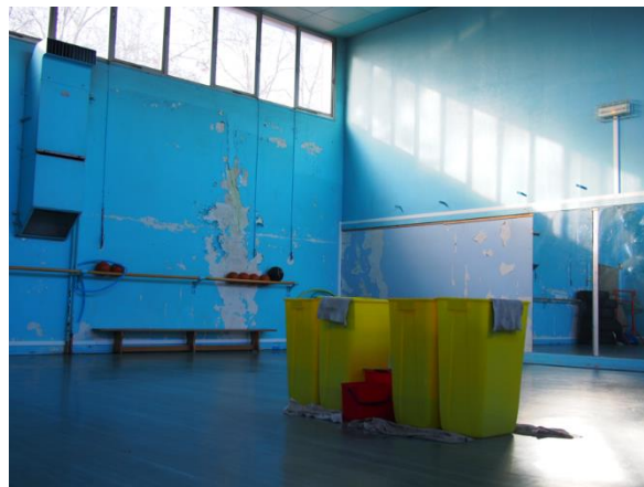
Le gymnase à Henry Ey, une des seules installations collectives, aujourd'hui condamné
