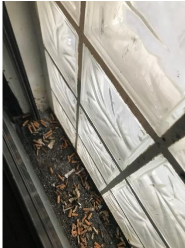
Mégots et débris dans l'interstice entre la fenêtre et la vitre opacifiée
