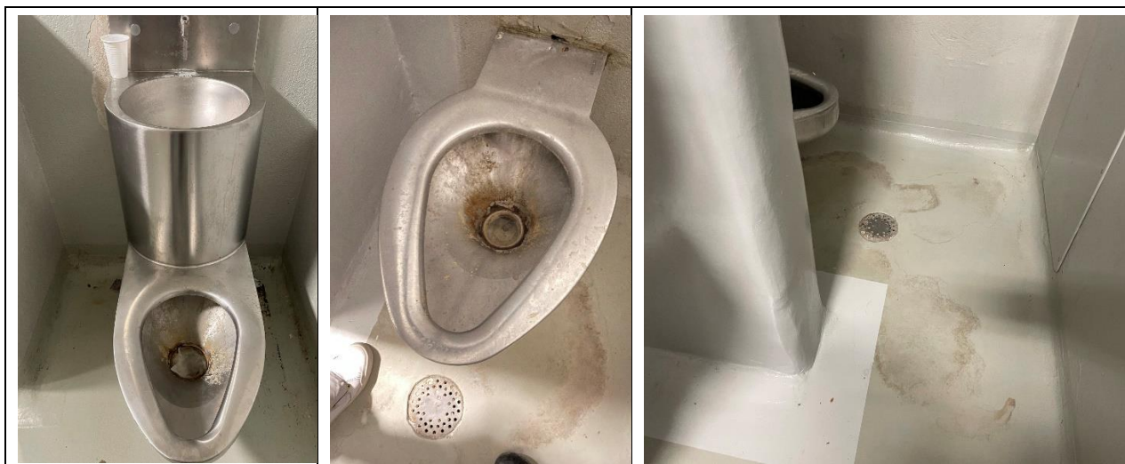
WC des cellules de garde à vue
