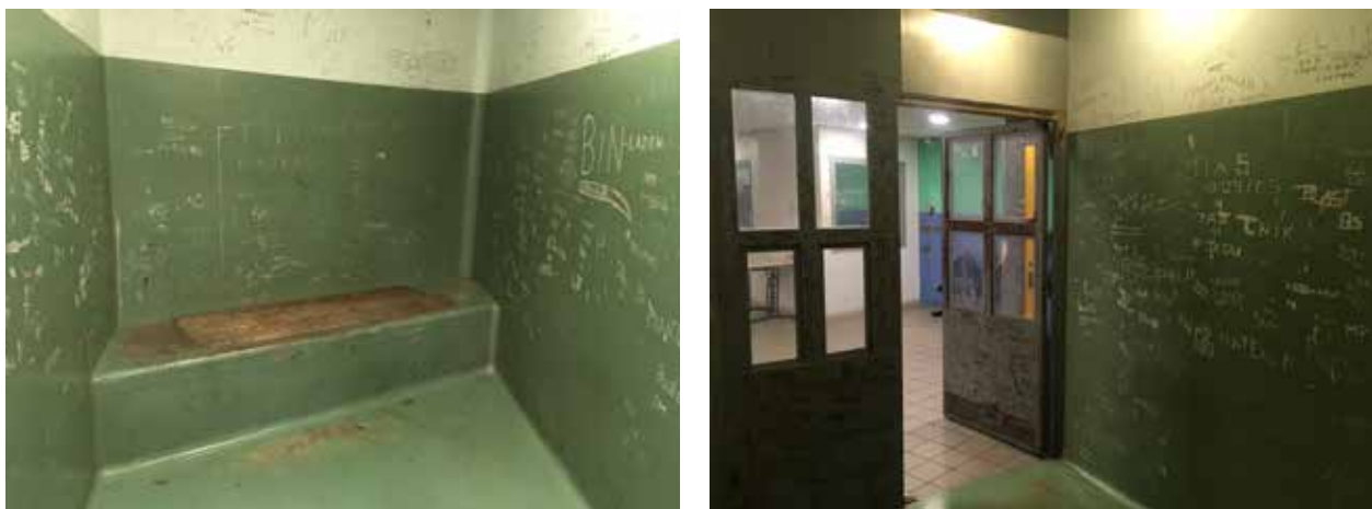
Vues d'une cellule de GAV
