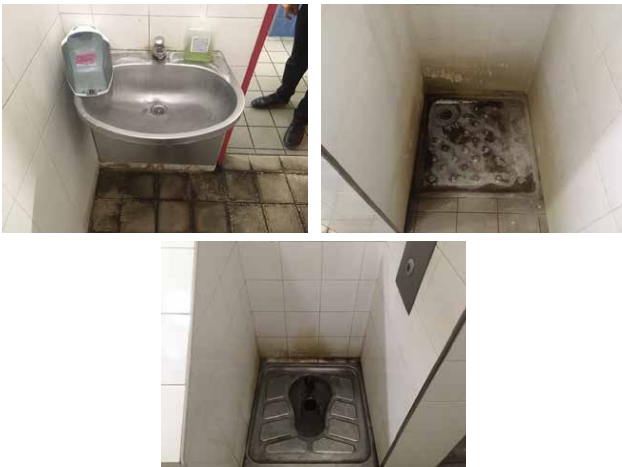
Vue d'un des sanitaires
