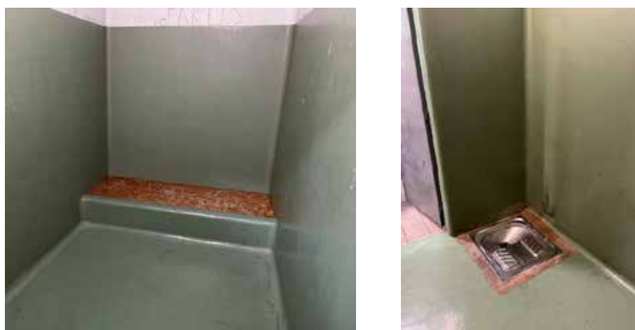
Une des quatre cellules de dégrisement
