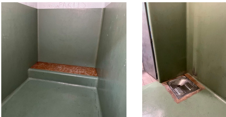
Une des quatre cellules de dégrisement
