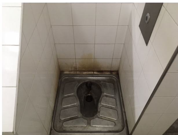
Vue d'un des sanitaires
