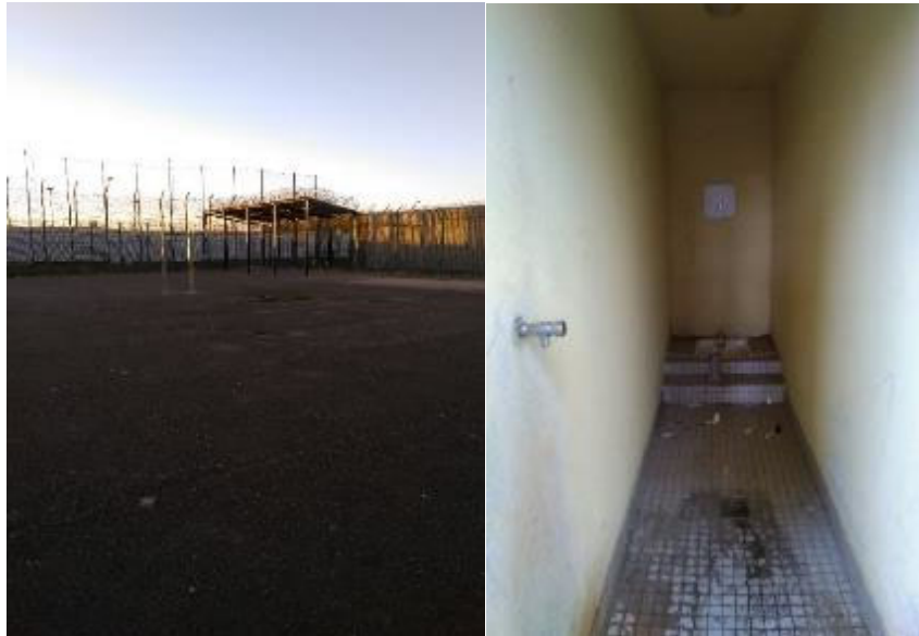
Cour de promenade - Toilettes et point d'eau situés dans le sas d'accès
