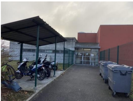
Façade QSL et parking deux roues
