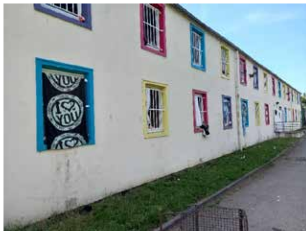
Façade du bâtiment d'hébergement
