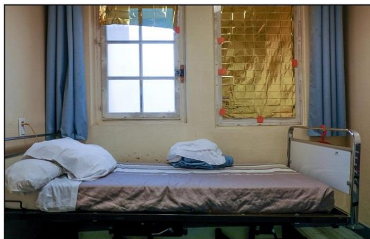
Vue des couvertures de survie servant de rideaux
