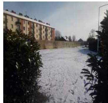
Un mur d'enceinte derrière une unité
