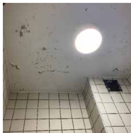
Plafond dans une salle d'eau
