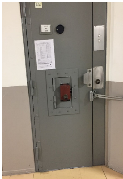
La porte d'une cellule du QI équipée d'une trappe de menottage et d'un entrebâilleur
