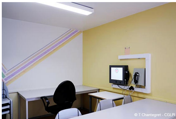
Le système d'interphonie installé en 2021
