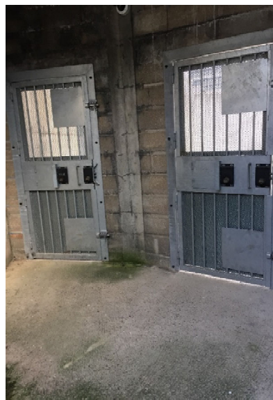
Les portes de deux cours de promenade équipées de trappe de menottage
