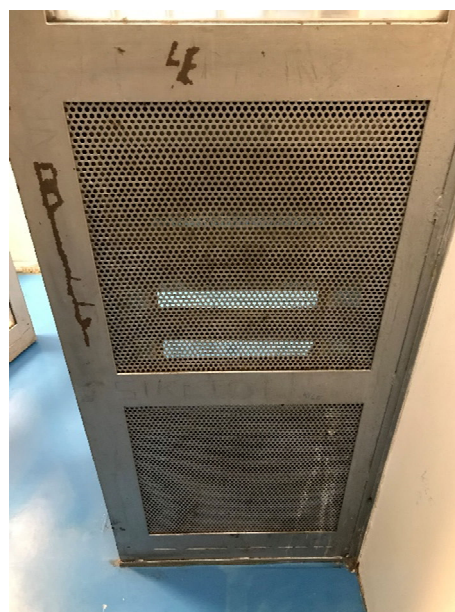
Le bloc métallique d'aération, vu du couloir (à gauche) et vu de la cellule (à droite)
