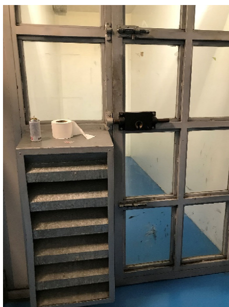
Le bloc métallique d'aération, vu du couloir (à gauche) et vu de la cellule (à droite)
