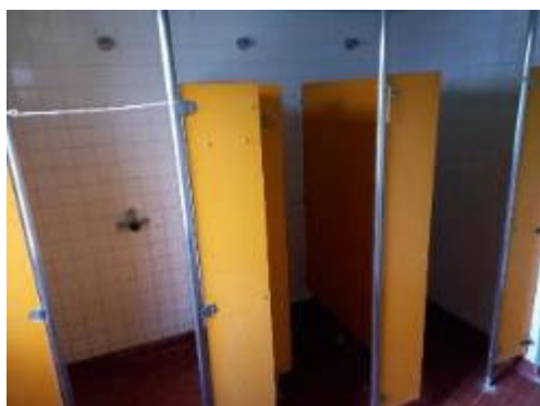
Les locaux de douches de différentes unités
