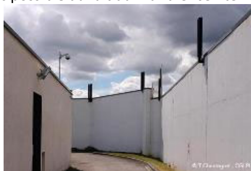
Vue du mur d'enceinte
