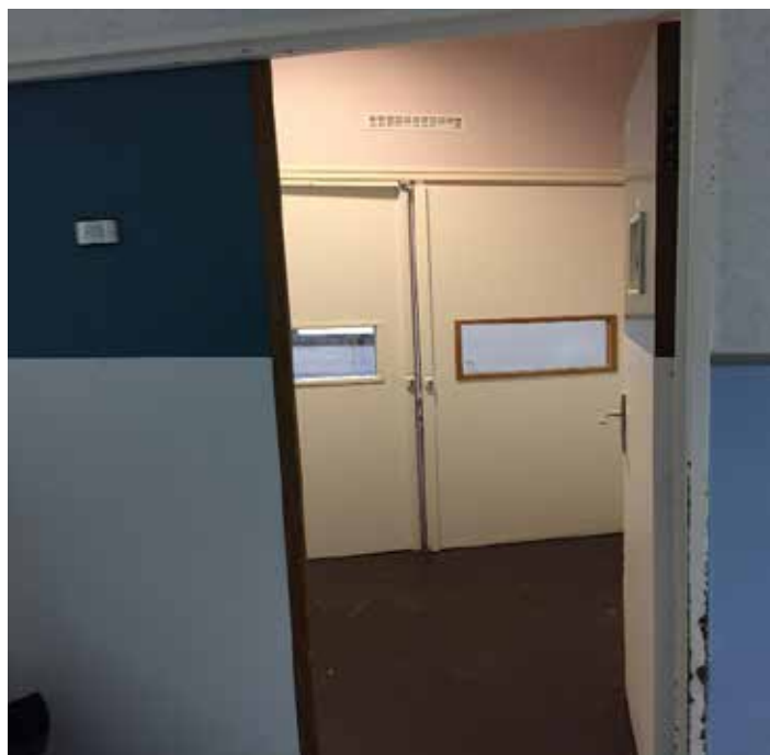
Vue de la porte d'entrée, du sas et de la porte de la chambre depuis le couloir des urgences
