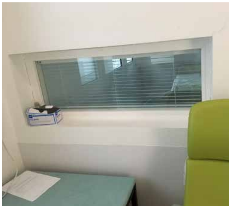
Baie de surveillance d'une chambre depuis la salle de garde
