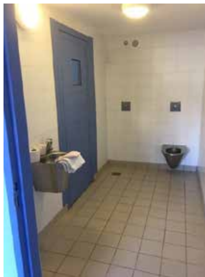
Salle d'eau de la chambre d'isolement
