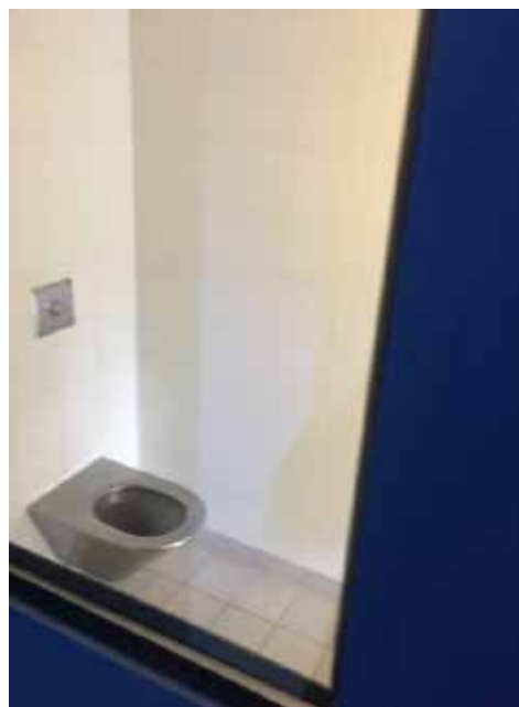
Hublot avec visibilité sur toilettes dans le sas
