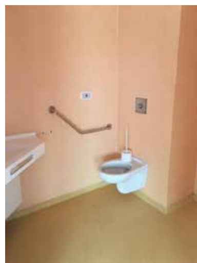
Salle d'eau de la chambre d'observation
