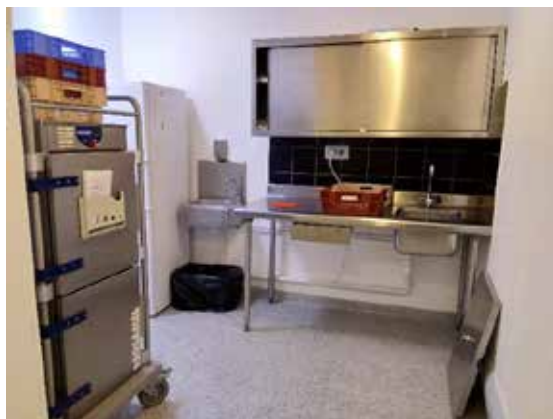
Vue d'un office au bâtiment maison d'arrêt
