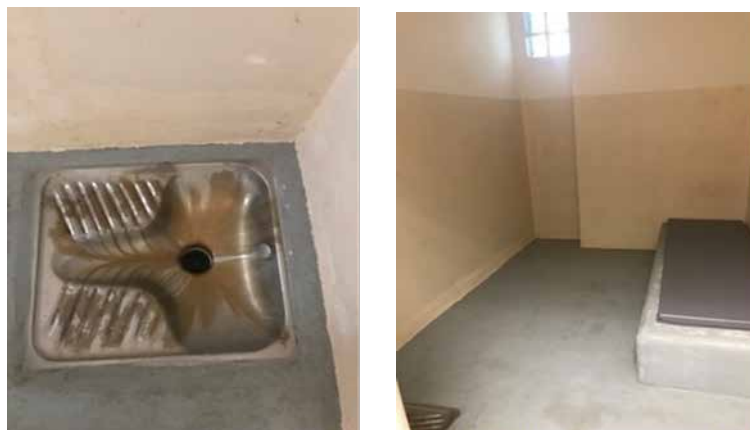
Vue des WC et du bat-flanc
