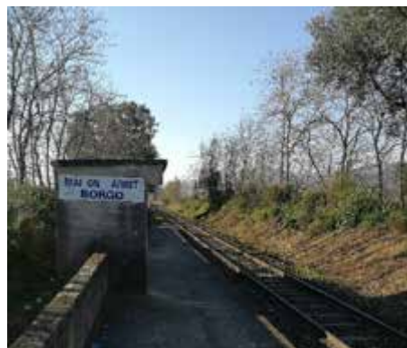
La station maison d'arrêt de Borgo
