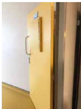
Porte de chambre
