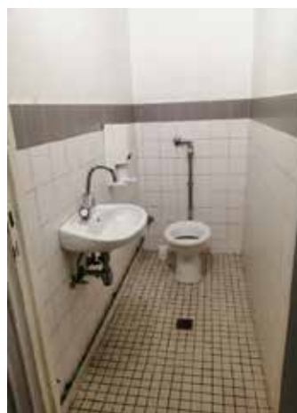
Des sanitaires avec un lavabo et des WC
