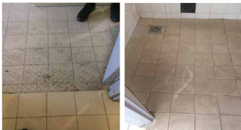
Sol des douches
