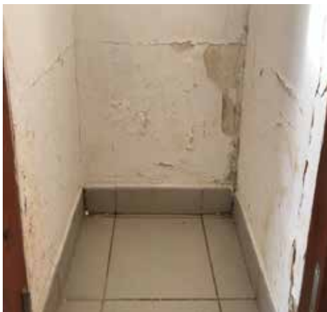
Placard de chambre semi-forte, unité A
