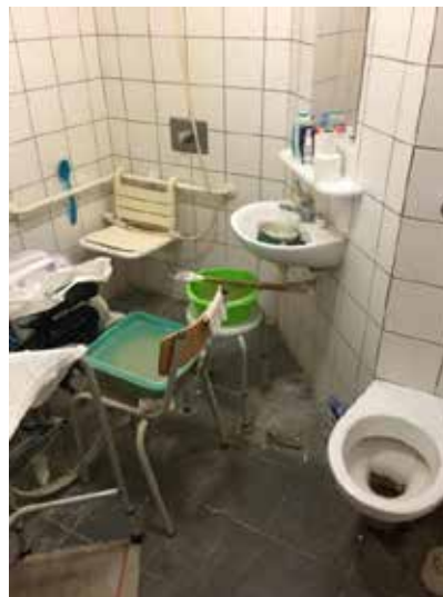
Salle d'eau d'une personne en fauteuil roulant
