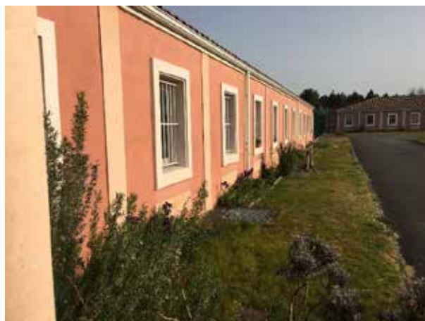
Extérieurs d'un pavillon
