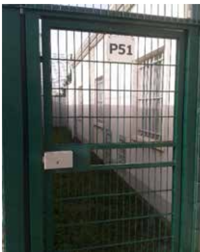
Vues sur fenêtres du QD
