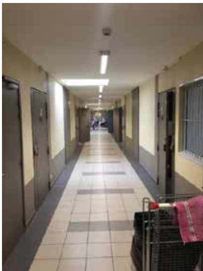
Couloir du bâtiment G dépourvu de barre d'appui
