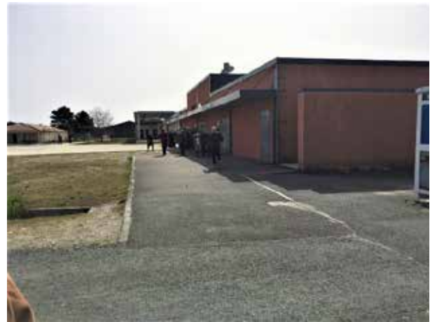
Bâtiment dévolu aux activités
