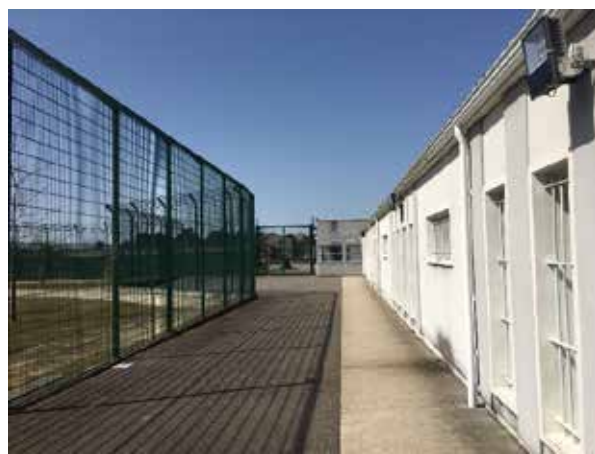
Bloc USMP à droite et bâtiment G en face
