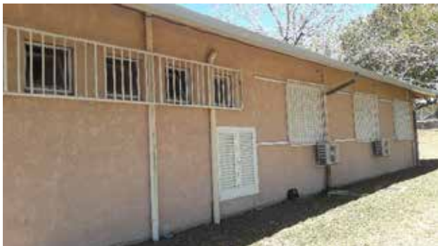
Sécurisation de l'arrière du bâtiment
