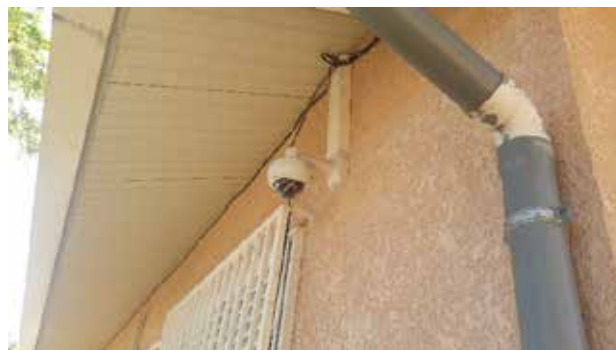
Barreaudage des fenêtres et caméra
