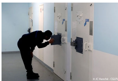
La trappe de menottage, utilisée comme fenêtre de communication
