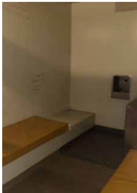
Cellule dite de « petite capacité », avec un matelas au sol
