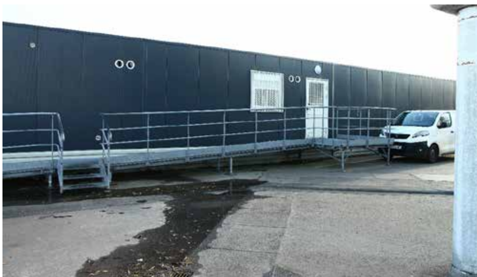
Le bâtiment modulaire vu depuis le porche de l'accès à l'unité judiciaire
