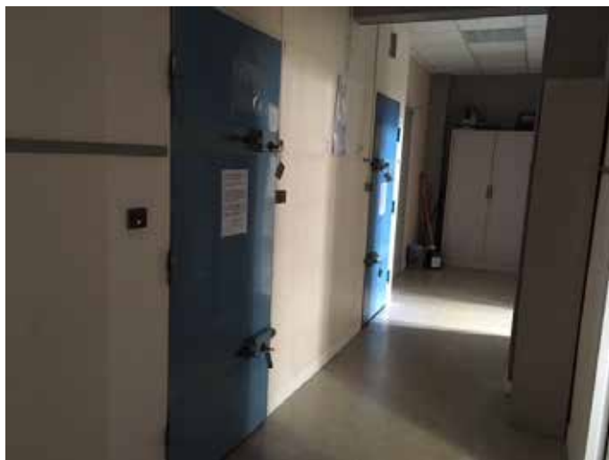
Couloir d'accès aux chambres de sûreté
