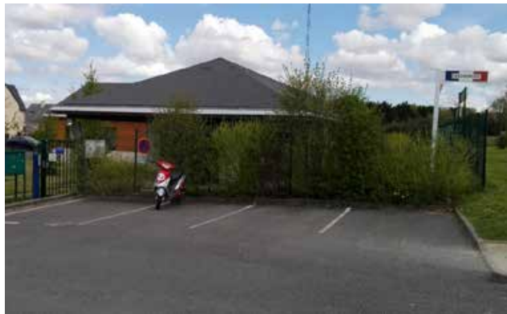
Figure 1 : Entrée de la brigade de gendarmerie de Sablé
