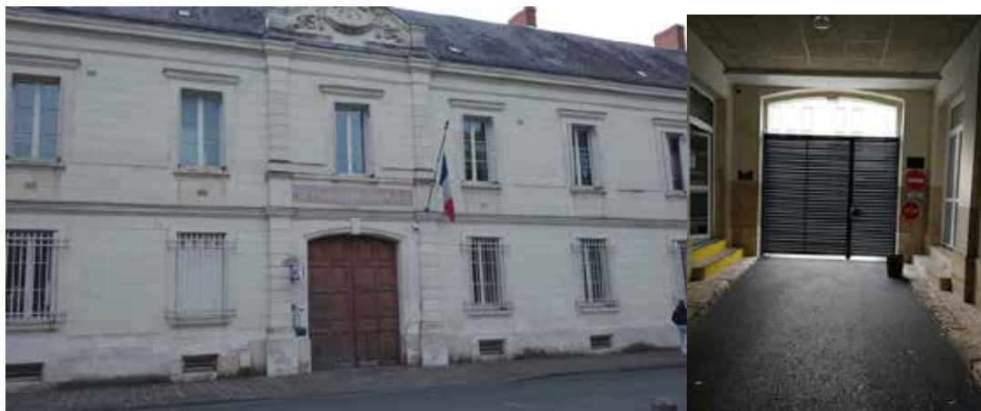
Entrée de la brigade et sas avec, à gauche, l'accès du public à la brigade
