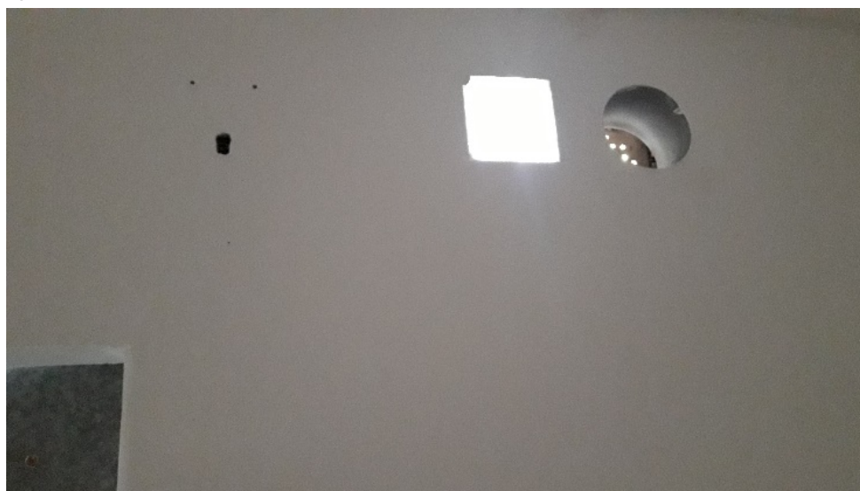
L'unique accès de lumière naturelle et la bouche d'aération
