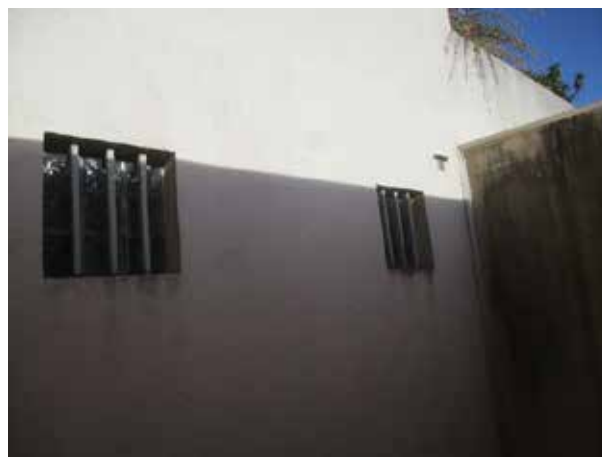
Le ciel et les fenêtres des chambres de sûreté vus de la cour de promenade
