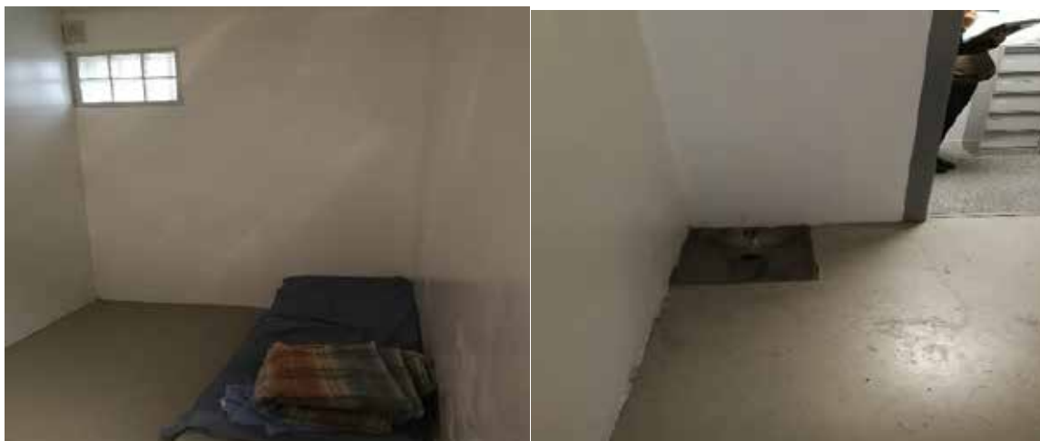
Cellule de garde à vue
