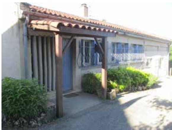
La BP de Cordes-sur-Ciel vue de la rue
