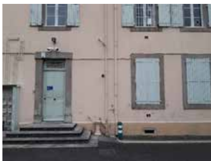
L'accès arrière du bâtiment, réservé aux personnes interpellées
