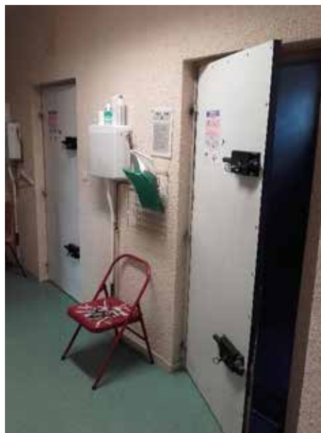
Les deux chambres de sûreté côté couloir
