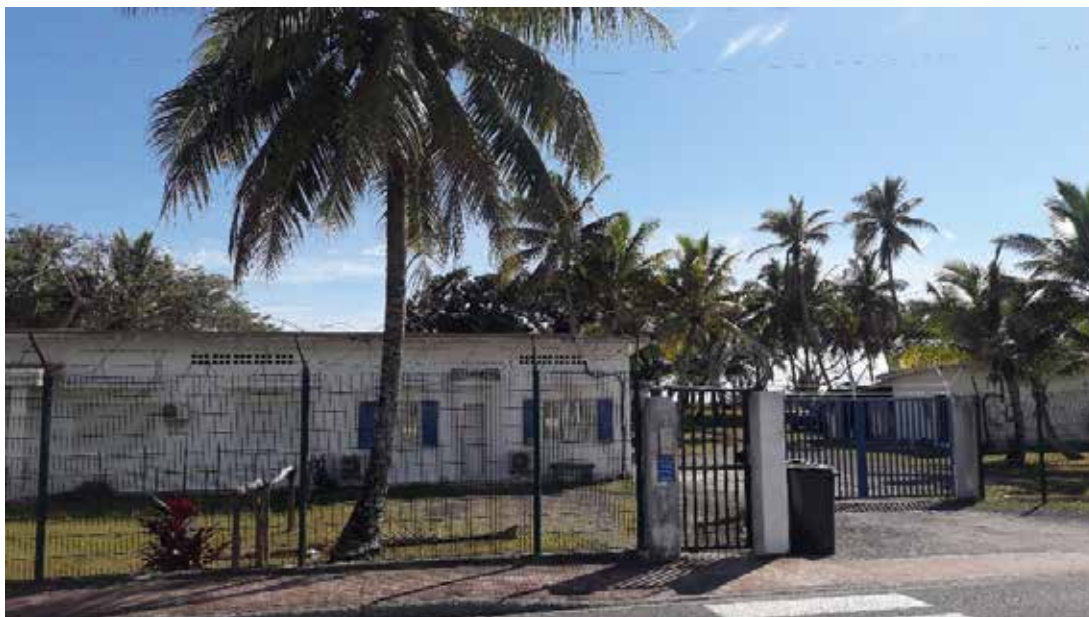
La brigade de We vue depuis la rue : bâtiment principal et, à droite, bâtiment abritant la geôle
