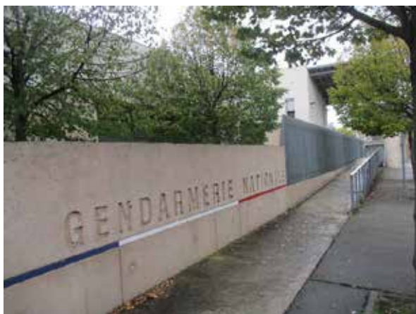
Le cheminement des personnes à mobilité réduite vers le hall d'accueil
