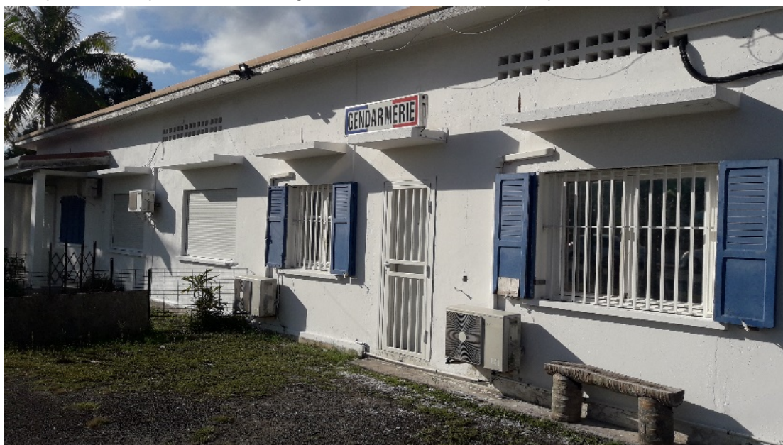
Le bâtiment abritant les bureaux des militaires, côté rue
