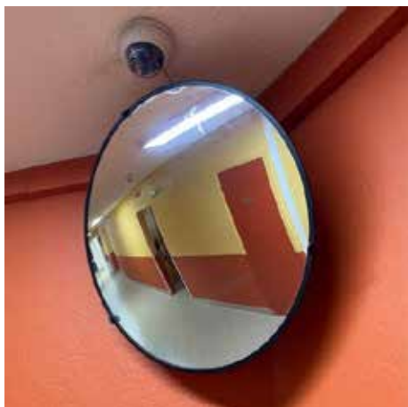
Caméra dans un couloir
