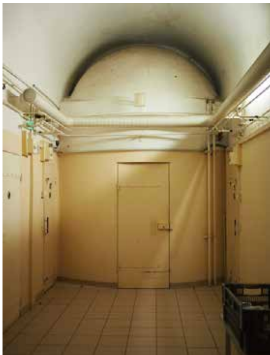
Le couloir du QSL des hommes
