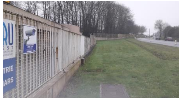
Clôture métallique ceinturant le site
