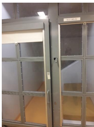
Vue du store occultant
