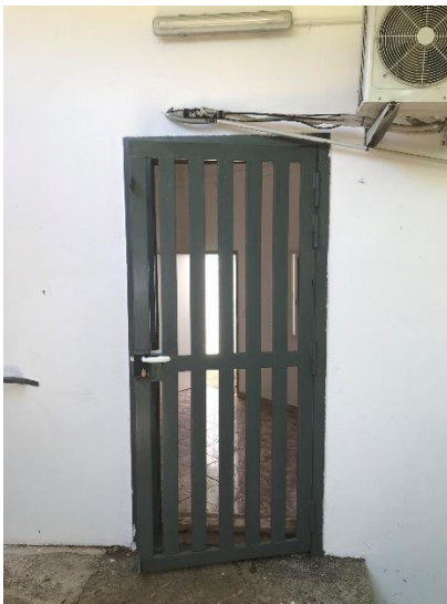
Entrée de la salle de repos
