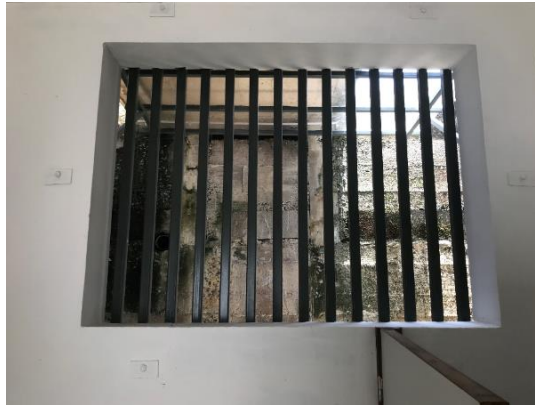
Une ouverture donnant sous la passerelle.
