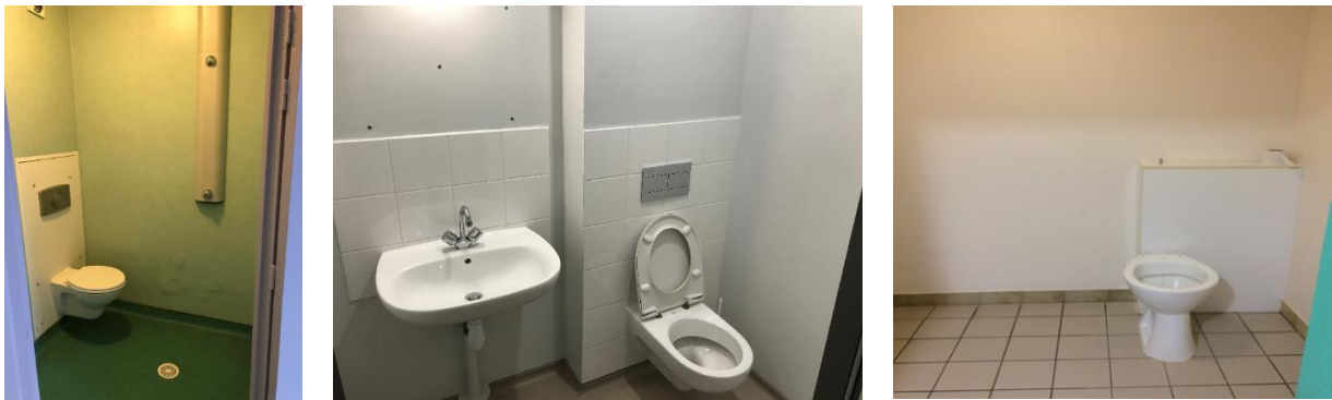
Sanitaires des chambres (Cap-Hornier à gauche, La Pléiade au centre et Lasègue à droite)
