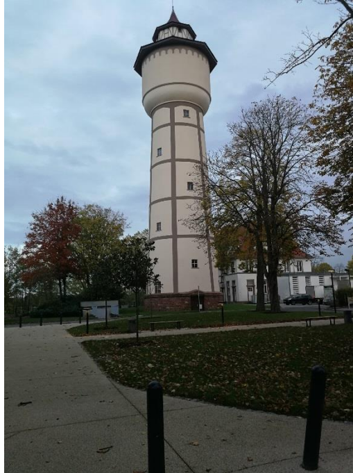
Le château d'eau
