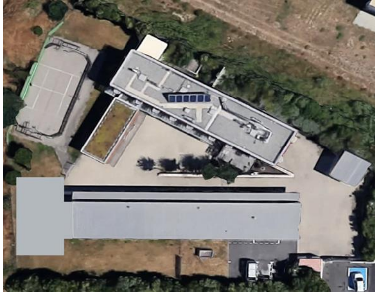
Site du CEF : bâtiment administratif au premier plan à l'entrée, bâtiment d'hébergement à l'arrière. A l'avant du bâtiment administratif, zone de terrain vierge
