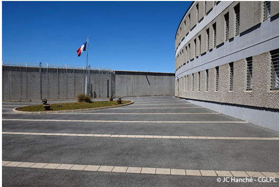
La cour d'honneur et le bâtiment administratif
