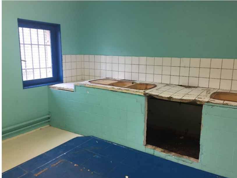
Office d'un étage du bâtiment 1
