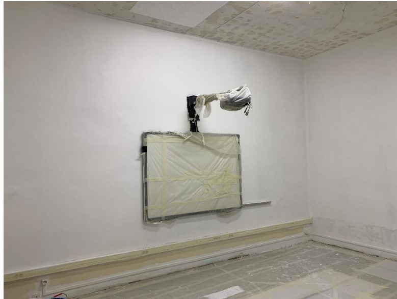
Salle de classe en cours de rénovation
