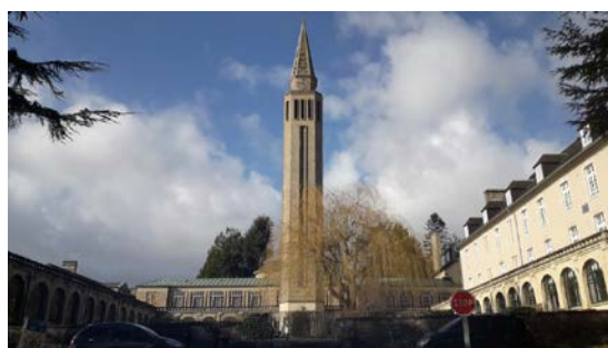
Le clocher et le cloître au centre du site de Picauville
