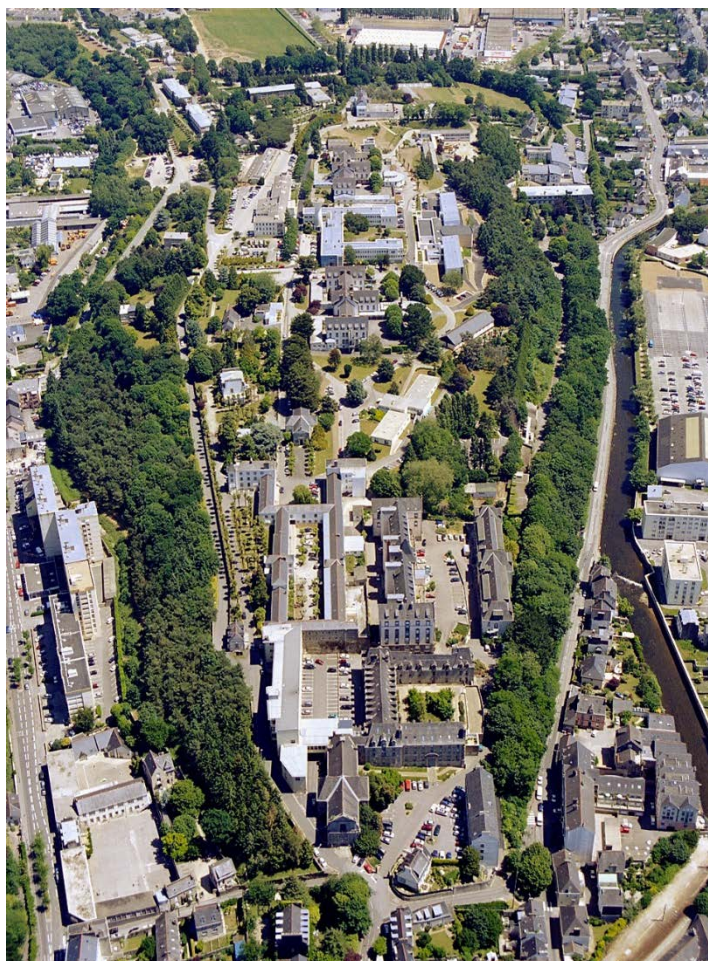
Vue aérienne du site hospitalier (source : EPSM Gourmelen) : au premier plan, partie historique dont la cession partielle est projetée
