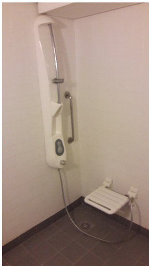
La douche PMR
