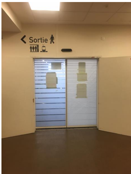
Entrée des urgences côté intérieur
