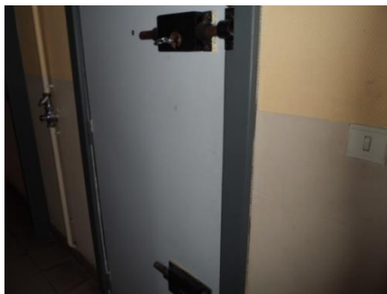
Une porte de chambre de sûreté avec les deux serrures, l'œilleton, les commandes de la chasse d'eau et de l'éclairage
