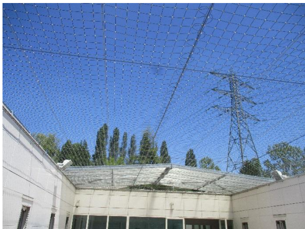
Le patio à ciel ouvert
