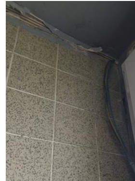
Fils apparents dans le local des douches
