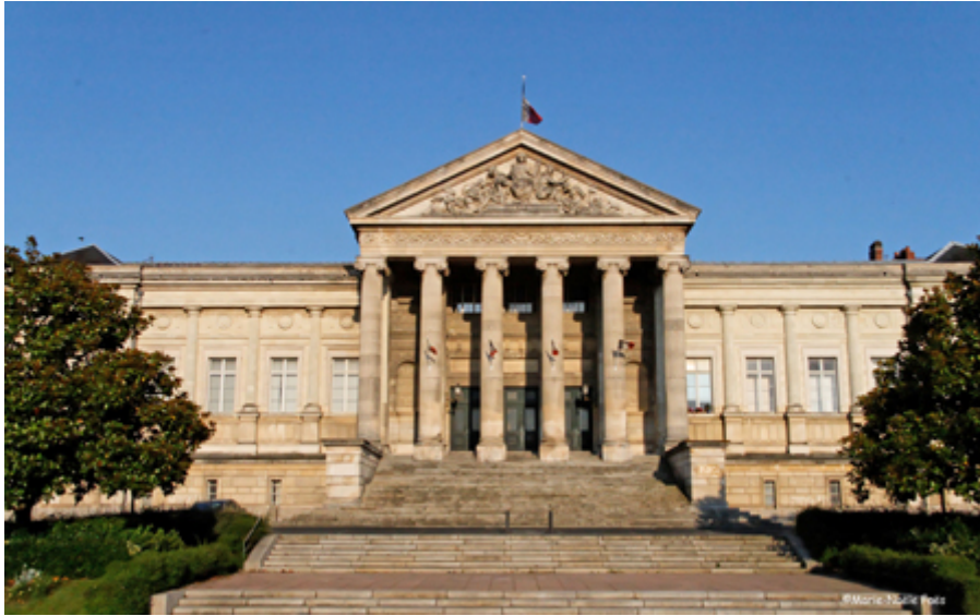
Façade de la cour d'appel et du tribunal
