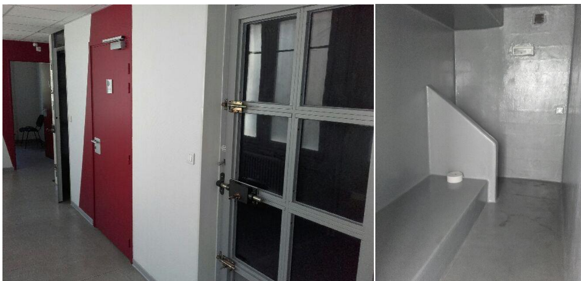
Vues extérieure et intérieure d'une cellule de garde à vue
